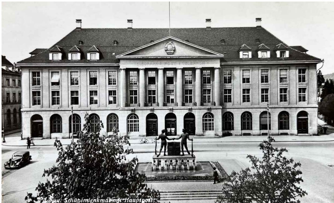
Abb. 82: Postgebäude 1915 mit Schützendenkmal von 1924. (Postkarte Photoglob Wehrli A.-G. Zürich)
