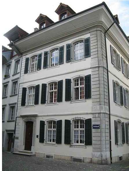
Abb. 32: Christkatholisches Pfarrhaus Aarau (ehemalige Helferei): Das Gebäude wurde 1784–1786 vermutlich nach einem Entwurf von Carl Ahasver von Sinner erbaut. (wikimedia)
