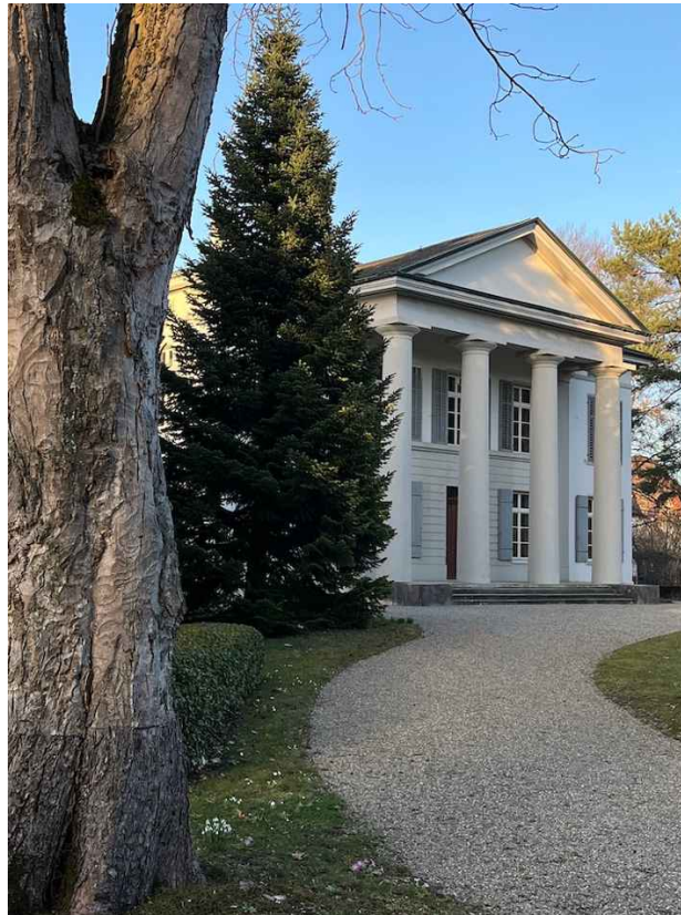
Abb. 66: Zugang zum Säulenhaus (2026).
