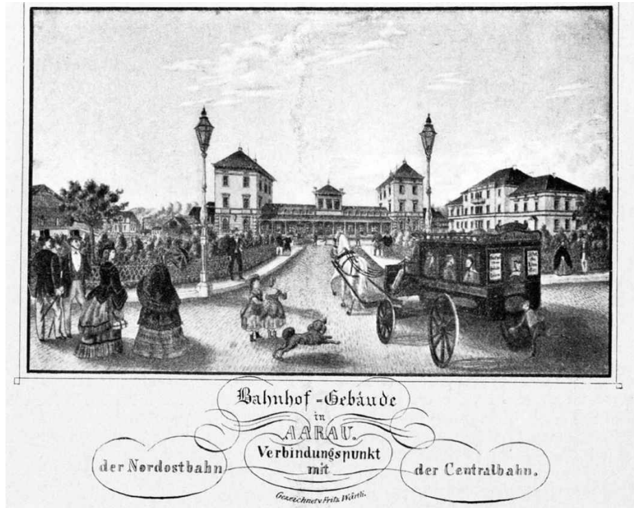
Abb. 46: Bahnhof und Postgebäude (rechts) in Aarau um 1870. (INSA Bd. 1, 101, vgl. 129 f. mit Abb. 87)
